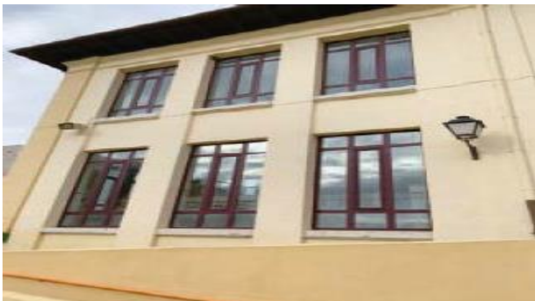
2/ - fasáda ošetřená přípravkem FACADE CR-0000
